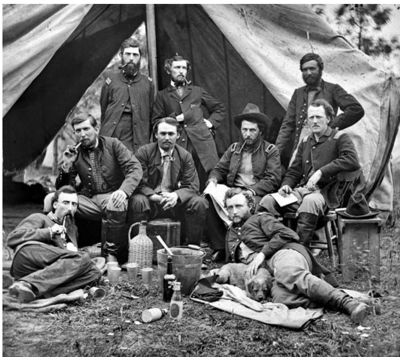
Katonai vezetők, Virginia, 1862
