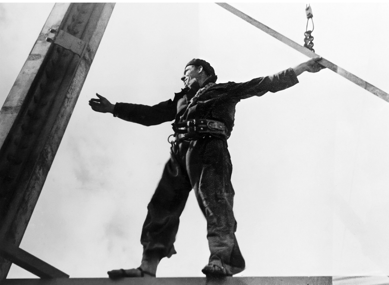
Organikus konstruktőr – A lakihegyi 314 méter magas antennatorony újjáépítése 1946-ban, a szerelő 90 méter magasan dolgozik (Fortepan / Rádió és Televízió Újság)
